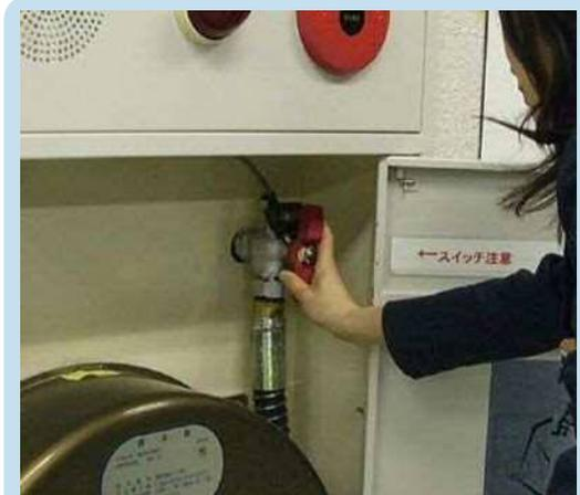
④ 消火確認後開閉バルブを閉める
