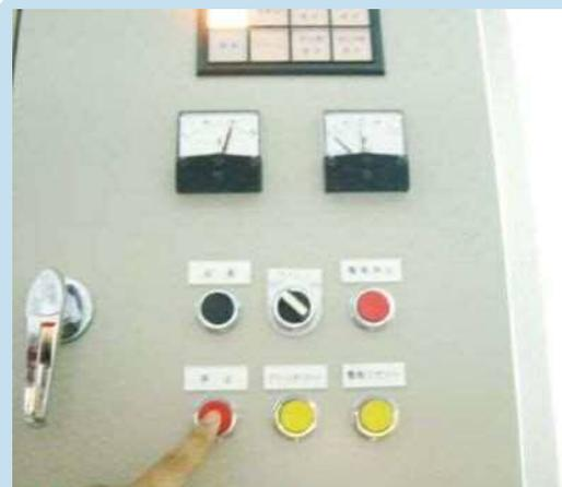
④ ポンプ制御盤（ポンプ室等）の停止操作を行う
