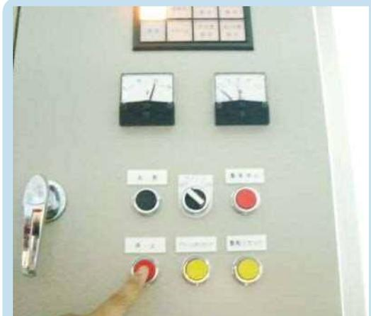
⑥ ポンプ制御盤 (ポンプ室等) の停止操作を行う
