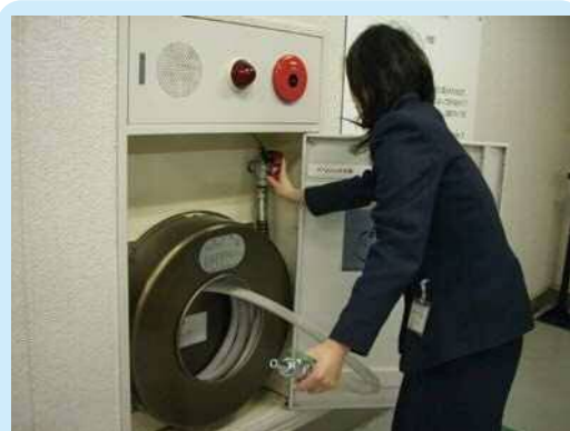
① ノズルのバルブを閉めた後 開閉バルブを閉める (時計回り：右回転)
