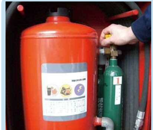
② 加圧用ガス容器のバルブを全開にする (反時計回り：左回転)
