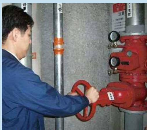
③消火を確認したら該当する制御弁を閉める (時計回り：右回転)
