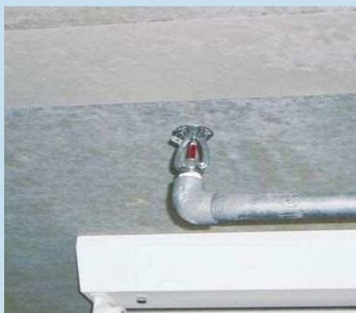
①天井に設置された感知ヘッドが熱を感知する
