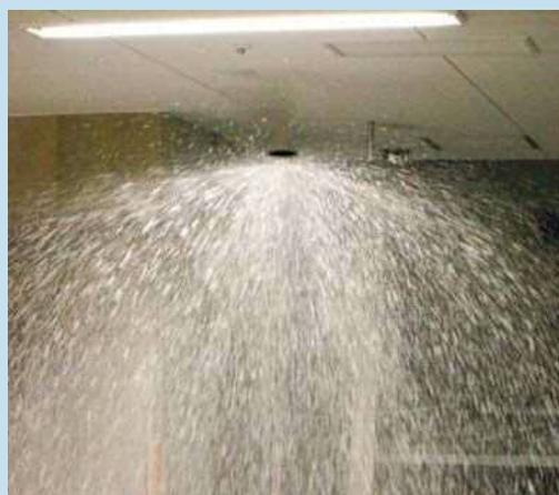
②自動的に専用ポンプが起動し、泡ヘッドから泡が放射され消火が行われる
