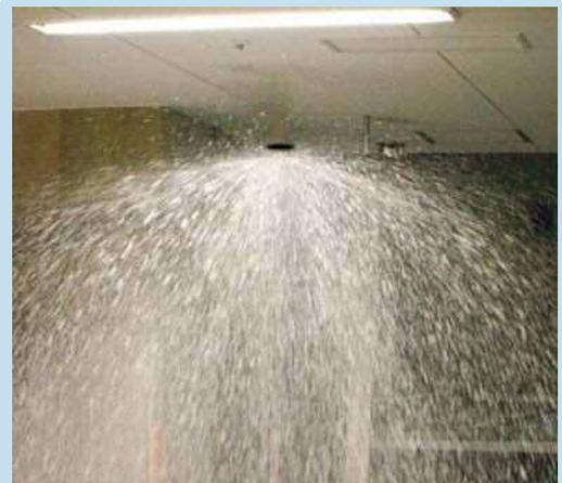
④ 専用ポンプが起動し、泡ヘッドから泡が放射され消火が行われる
