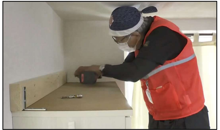
実際の施工の様子
