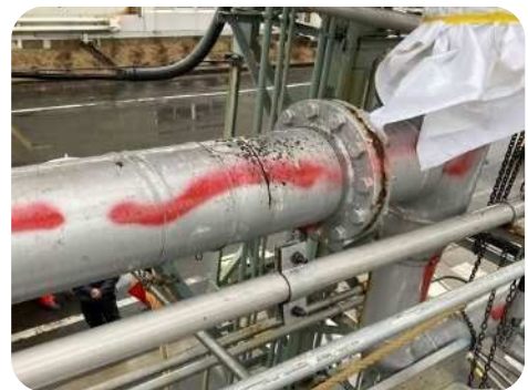
↑ 切断作業中の屋外給水施設の配管
