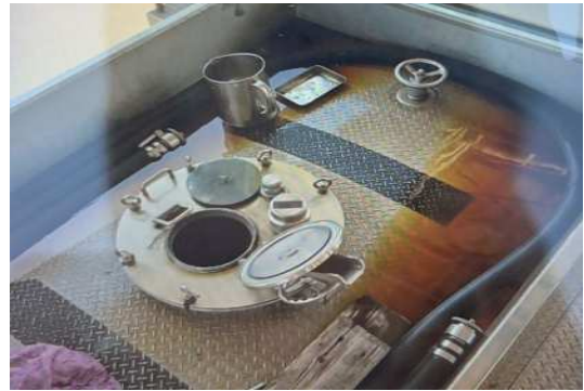
↑ 移動タンク貯蔵所上部の漏洩状況
