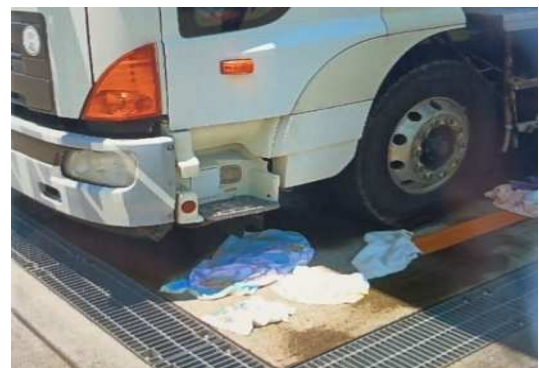
↑ 漏洩物の除去状況
