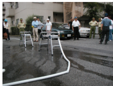
応急用給水装置 組み立て訓練
