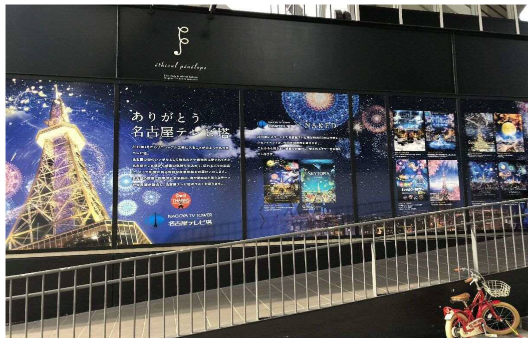
再整備工事直前のテレビ塔 1階部分
