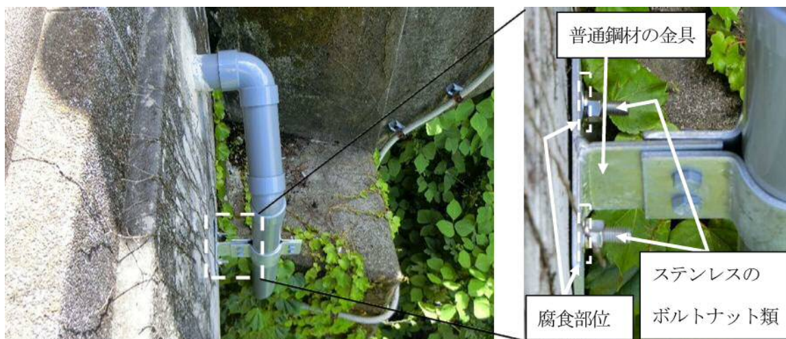
排水管の設置状況
