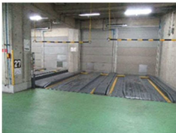
(写真③⑥) 南区役所 地下駐車場
