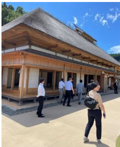
↑ 復旧した主屋の外観
