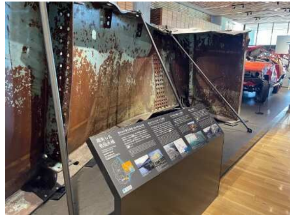
↑ 津波により流失した気仙大橋
