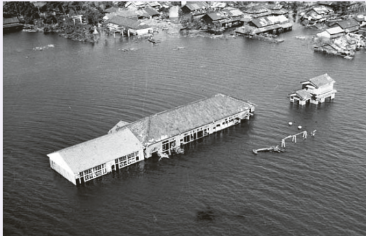
伊勢湾台風による浸水で孤立した港区の南陽小学校茶屋分校
