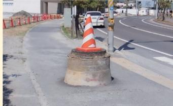
地盤の液状化で浮上した下水マンホール(千葉県浦安市)
