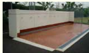
上下水道局 職員が開放する 常設給水栓
