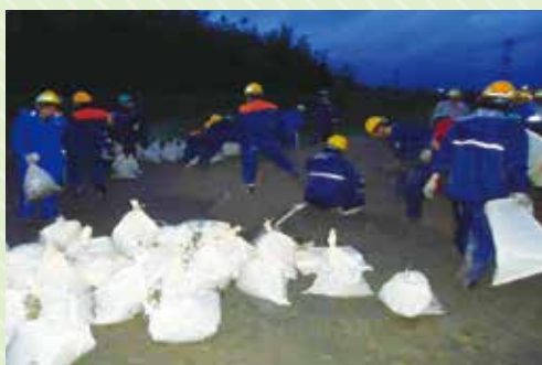
土のう作業の様子(台風15号時)
