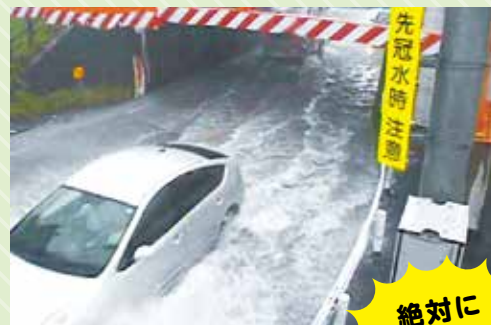
冠水したアンダーパス
