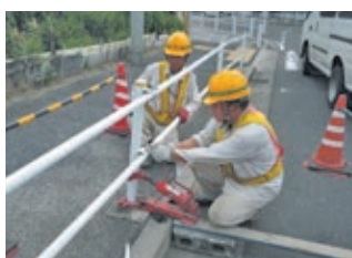
防護柵の補修
