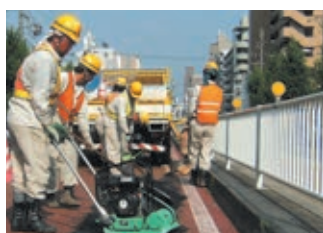
道路の舗装修繕
