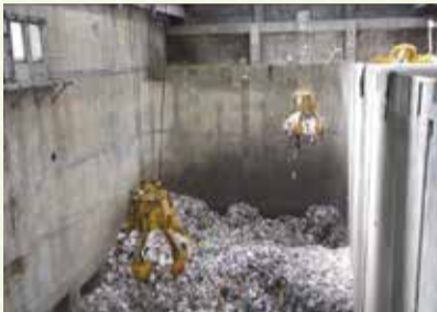
富田工場のごみピット
