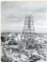
建築中のテレビ塔 TV Tower under construction
