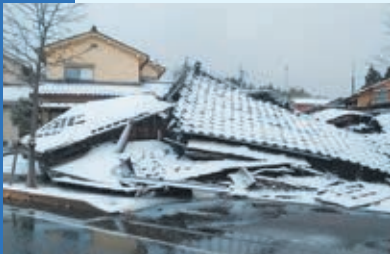
倒壊した家屋
