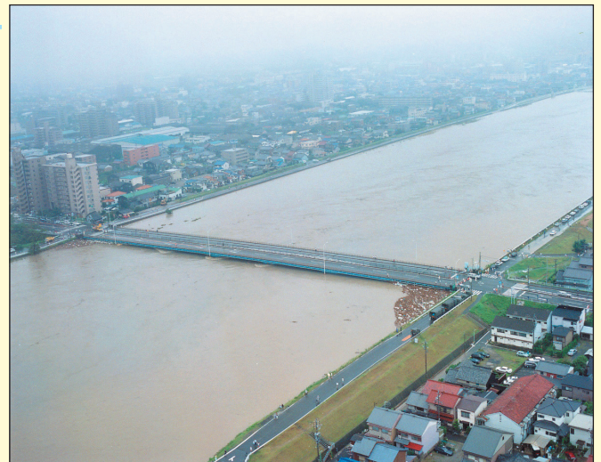
東海豪雨時の一色大橋
