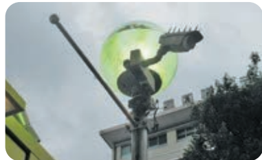
防犯灯・防犯カメラの設置
