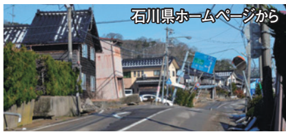
液状化の影響で道路が波打つ様子
