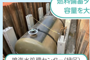
鳴海水処理センター(緑区)
