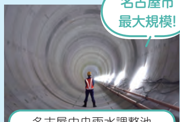
名古屋中央雨水調整池
