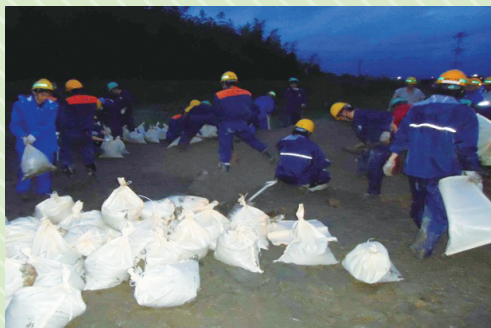
土のう作業の様子(台風15号時)
