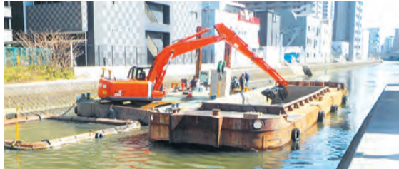
堀川で川底を掘る工事の様子
