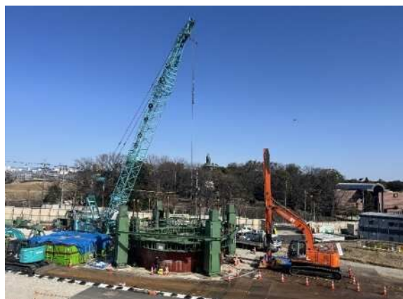
（縦穴築造の様子）
