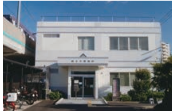
緑土木事務所
