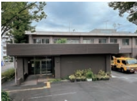
熱田土木事務所
