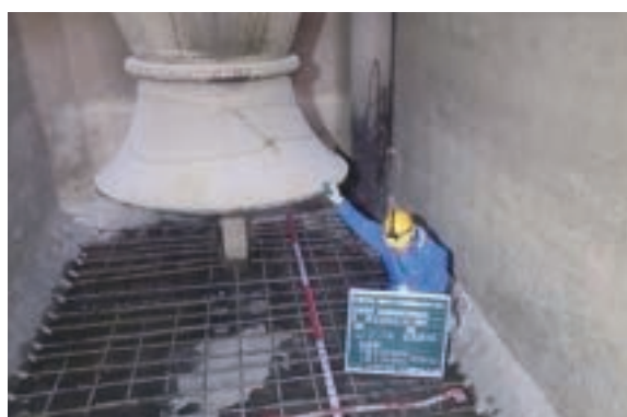
曲げ補強施工状況
