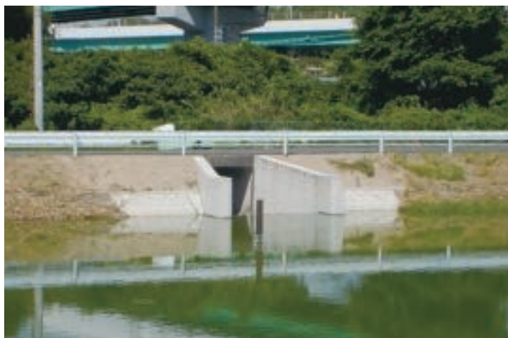
放流施設の改良(平野池)
