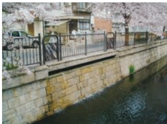
図3 打出水処理センターの下水再生水の導水
