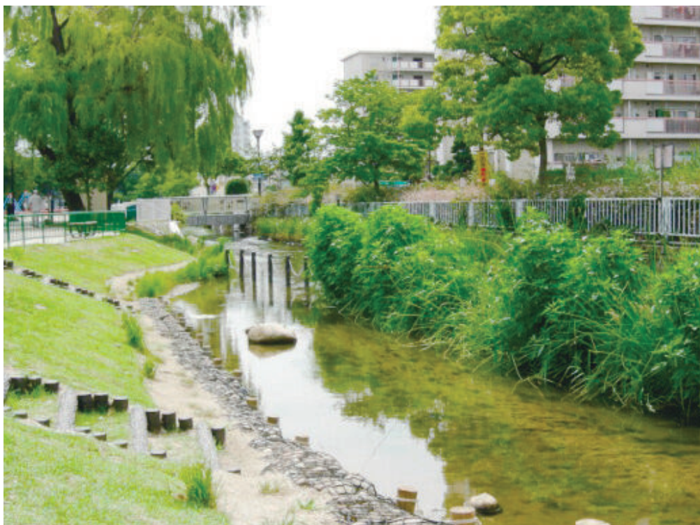
水の回廊 整備前後
