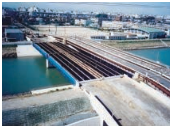
星園橋の施工状況
