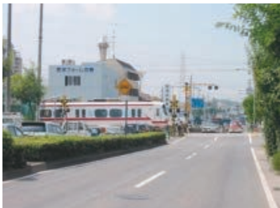
鳴海4号踏切部状況
