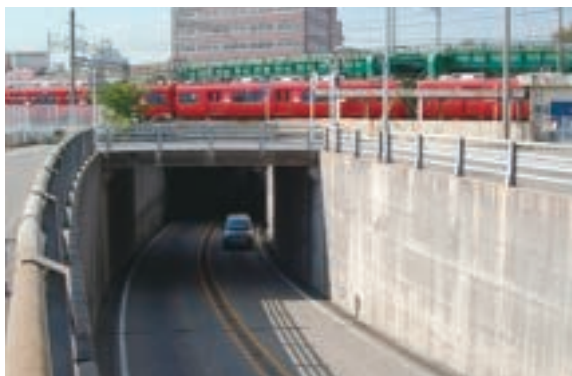
工事完了後(東から西を望む)
