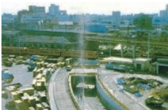
秋葉架道橋(工事中)
