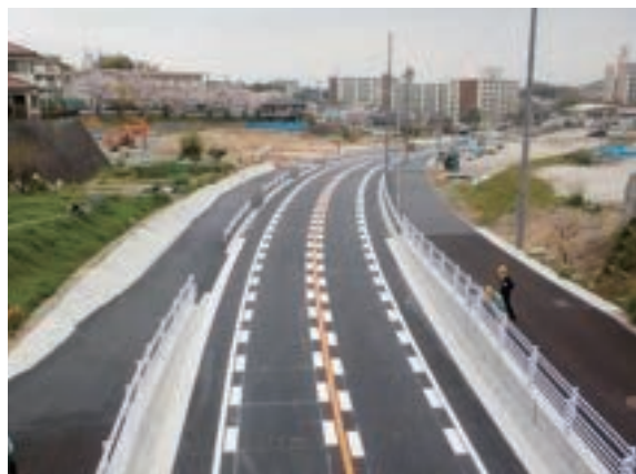
開通後(令和5年3月)
