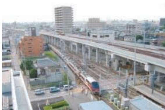
仮線運行状況
