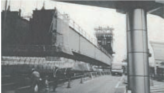
架設状況(一括吊上げ工法)
