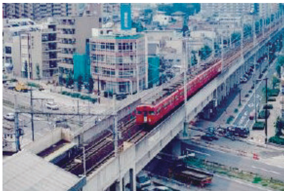
国道19号交差部(高架化後)
