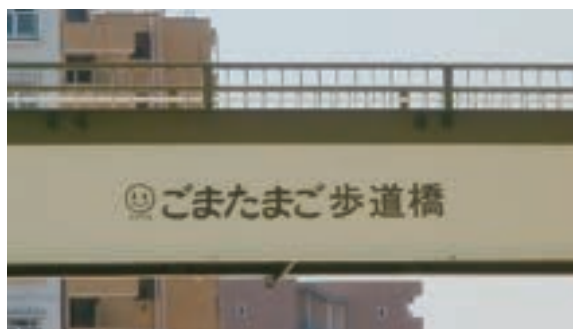
契約歩道橋の一例
