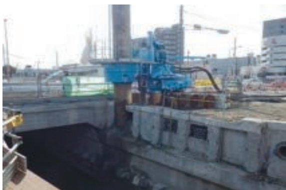
ジャイロパイラーによる縁切り
