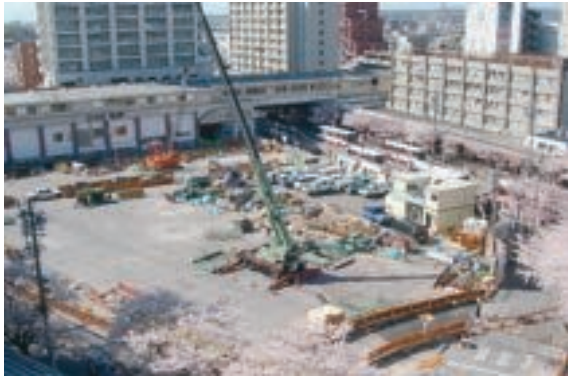
藤が丘駅現場写真
