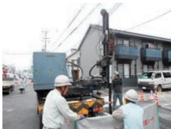
防音対策を施しながらの施工風景
