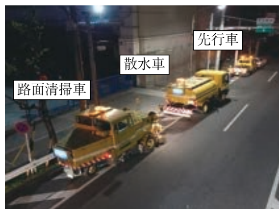
車道清掃状況
