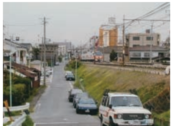
名鉄常滑線西側既存側道
