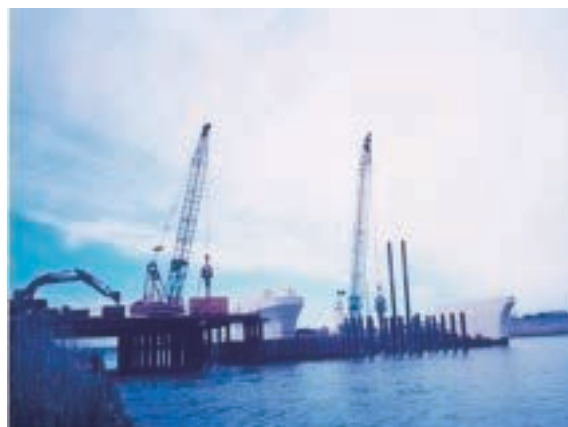
下部工施工状況(陸上+水上同時施工)
