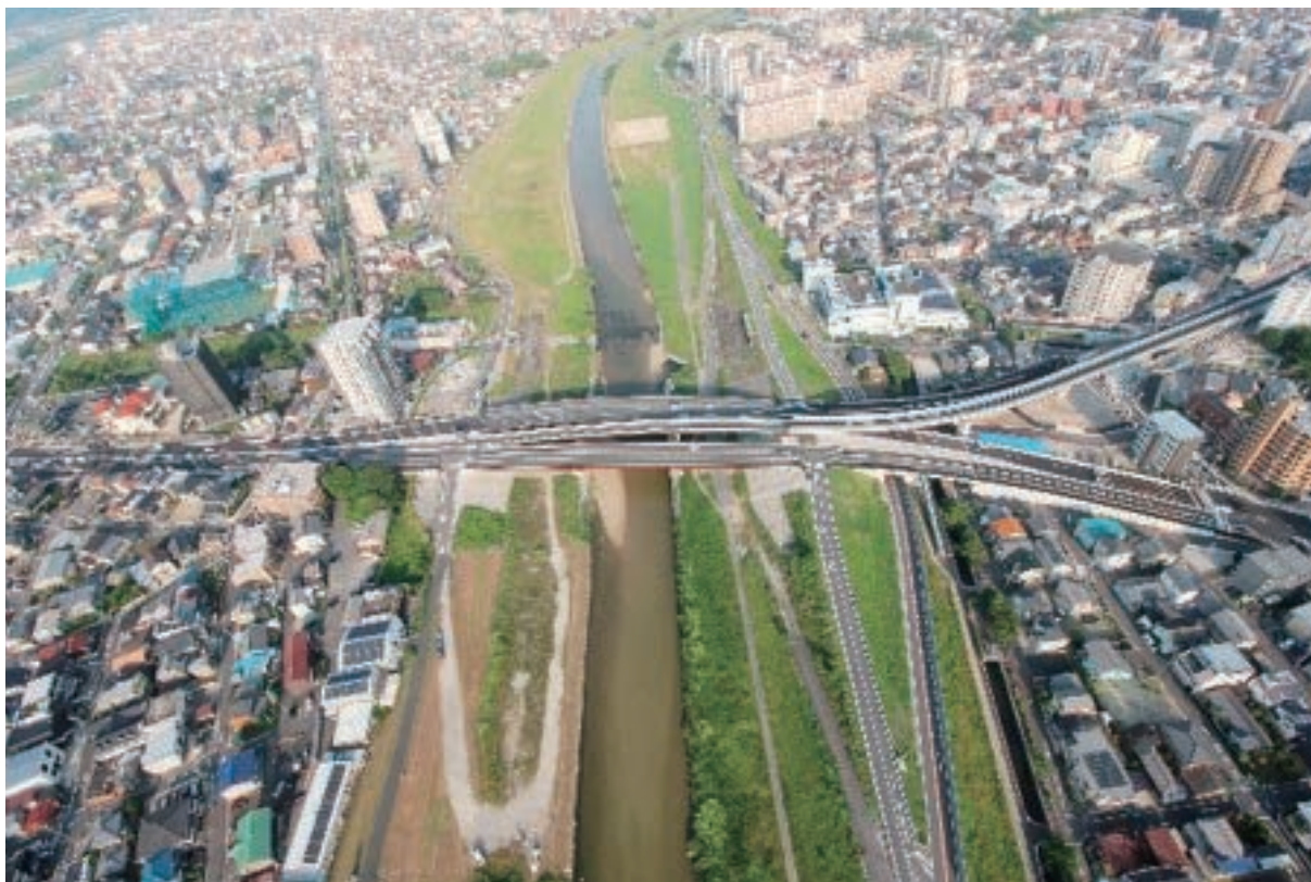
開通後の三階橋
