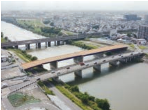
枇杷島橋の施工状況 (R4.6)
