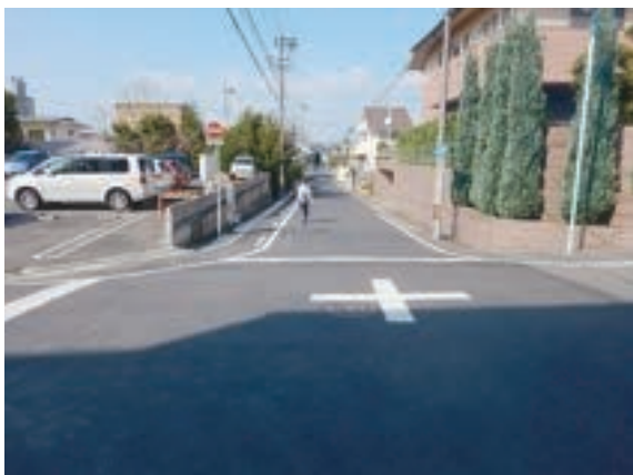
道路復旧工事後
