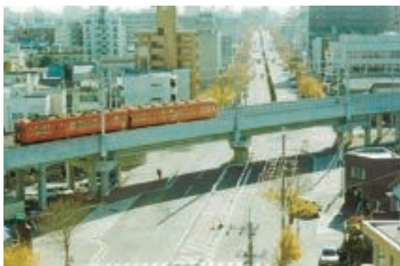
国道19号との交差部
