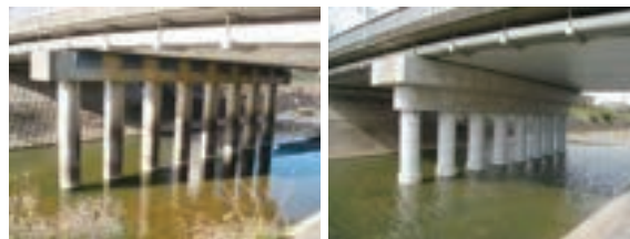
下焼田橋の耐震補強
