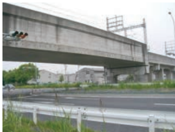
国道302号交差部近景
