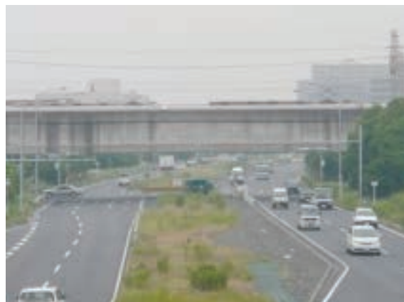
国道302号との立体交差
