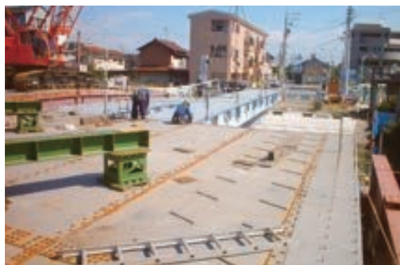
上部工架設状況
