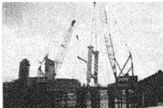
上部工施工状況
