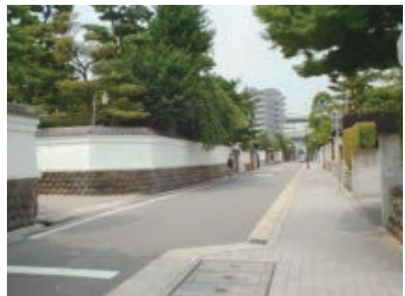
白壁赤塚線整備後
