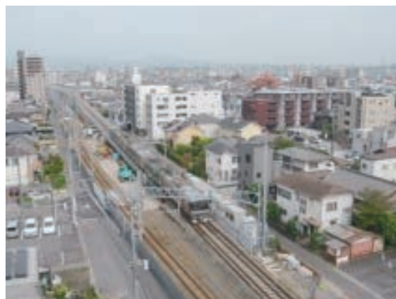
上り線高架切替後
