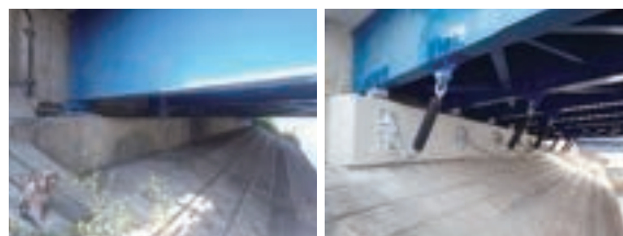
両茶橋の耐震補強
