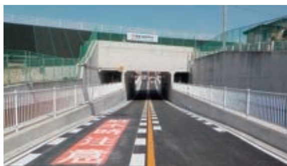
開通時のトンネル部(令和3年3月)
