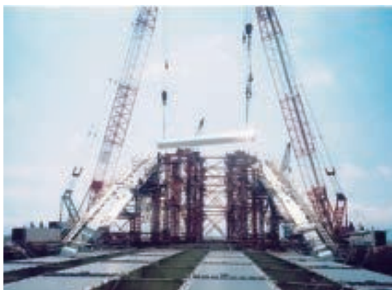
ニールセンローゼ架設状況
