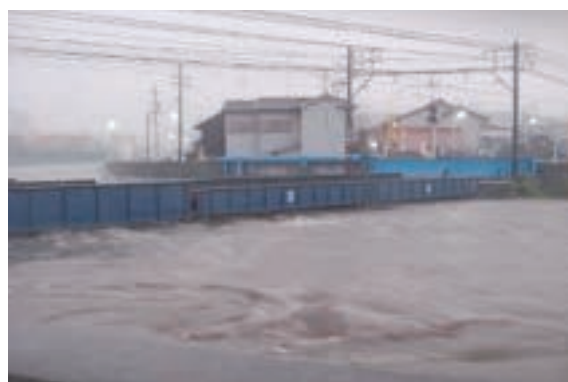
陸閘門(名鉄名古屋本線橋梁)
