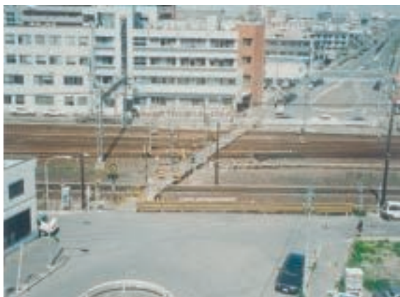
白山・八田4号踏切(着工前)
