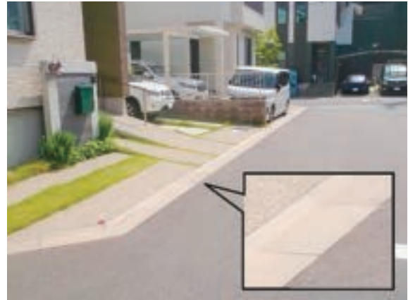
V形側溝の施工例
