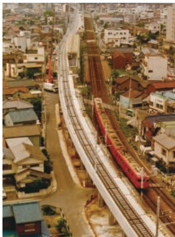
名鉄常滑線(新堀川～山崎川)事業中状況
