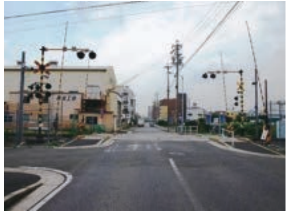
三番通踏切(拡幅後)
