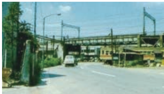
工事着手前の秋葉踏切
