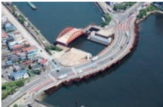
施工状況(アーチ仮置き)
