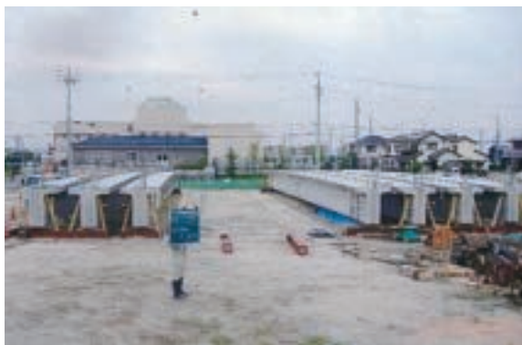
現場打ちPC桁製作状況
