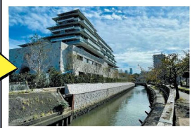
護岸の整備（西区 堀川）
