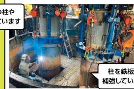
橋脚の補強（港区 小碓中橋）
