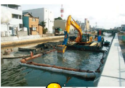
河川のしゅんせつ（中川区 堀川）
