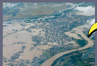
河川堤防の決壊（平成27年 鬼怒川）
