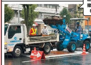
道路啓開訓練
