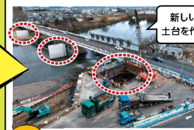
橋の改築（北区・守山区 水分橋）
