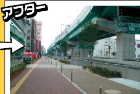
無電柱化（中川区 江川線）事業後
