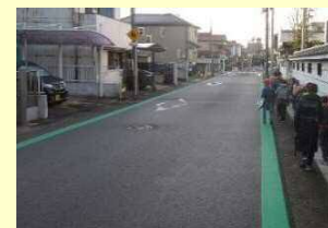
【路肩カラー舗装】
