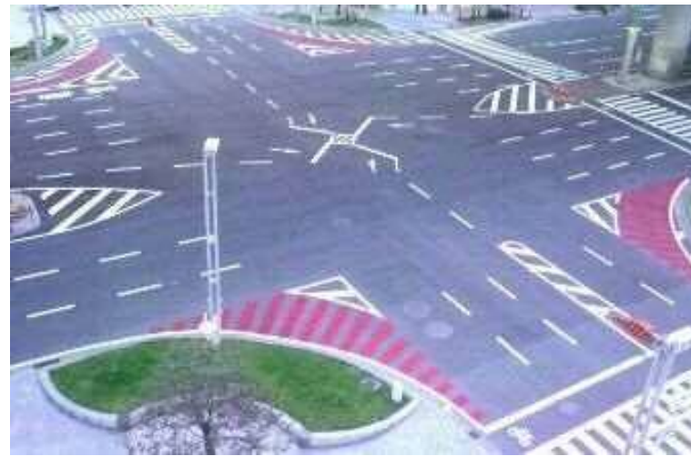
交差点巻き込み事故対策カラー
