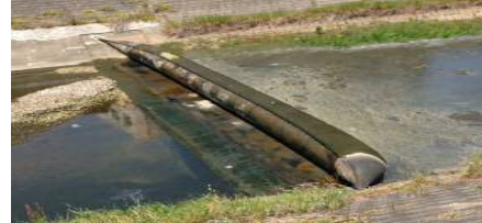
↑ラバーダム：ラバーダムとは堰の一種で、ゴム引布製のチューブに空気を入れて川をせき止めます。北区境近くの北名古屋市内の大山川に設置されたこのダムは、北区の喜惣治地・大我麻地区へ農業用水を供給しています。
