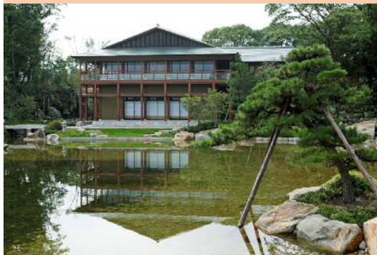
観仙楼（庭園側より）
