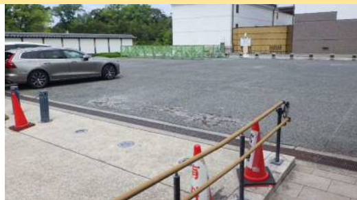
透水性コンクリート舗装
