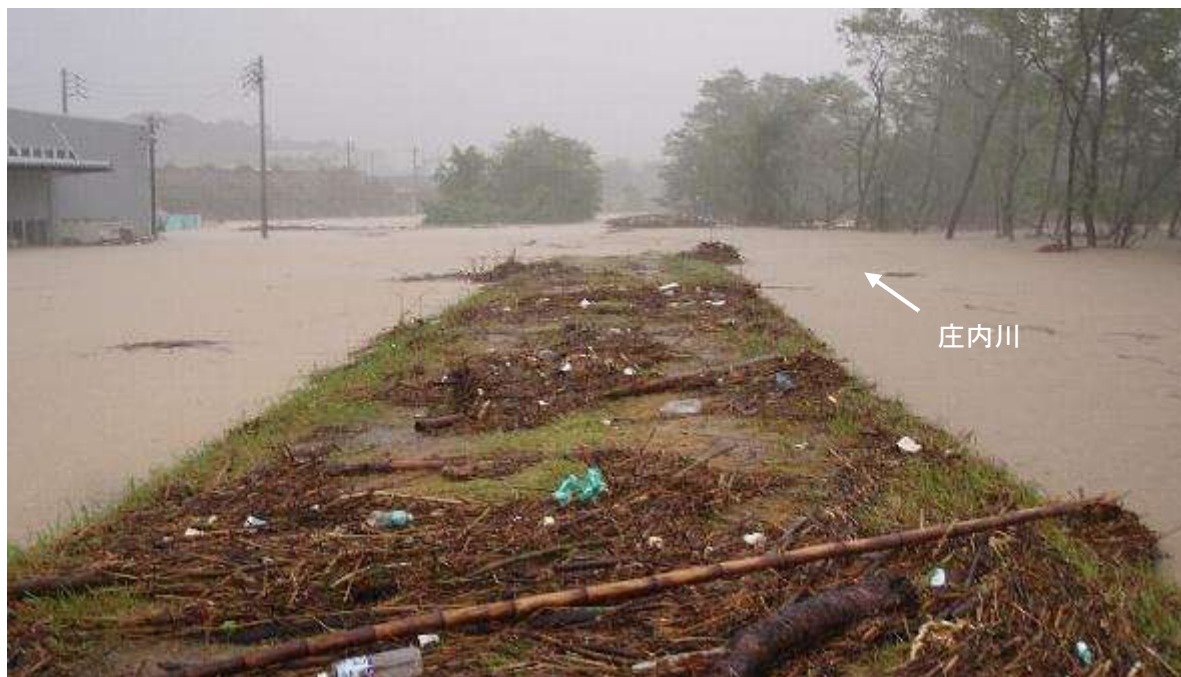
平成23年9月20日 台風15号 志段味地区越水箇所
