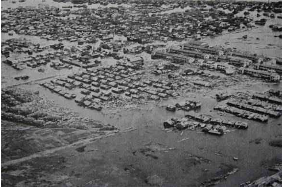
高潮と流木で死者 660 人を生じた南区白水住宅一帯（『伊勢湾台風災害誌』より）
