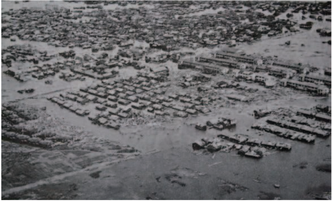
高潮と流木で死者 660 人を生じた南区白水住宅一帯（『伊勢湾台風災害誌』より）
