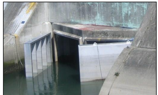
完成した水門
