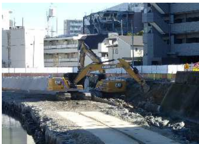
堤防の取り壊し作業
