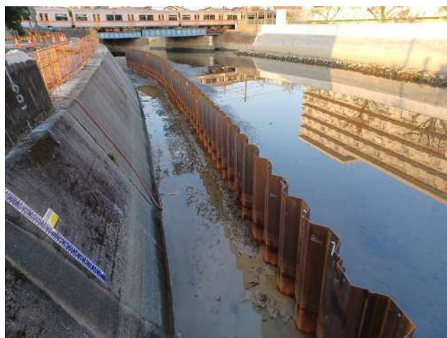
河川内に矢板を設置
