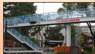
対象歩道橋の様子
