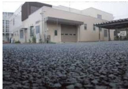
【写真14】透水性舗装の駐車場
