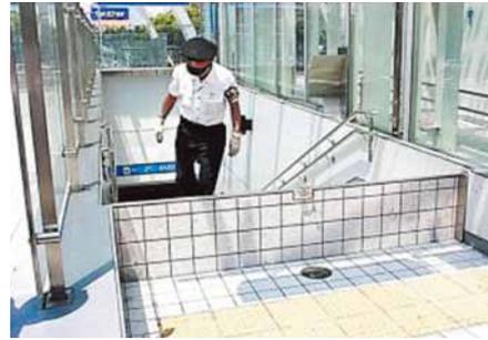
【写真20】地下鉄の起上方式止水板
