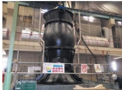
【写真12】ポンプ施設の改築にあわせた能力増強
