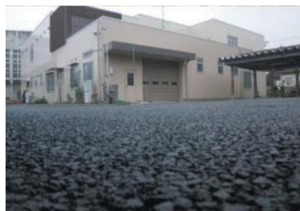
【写真14】透水性舗装の駐車場
