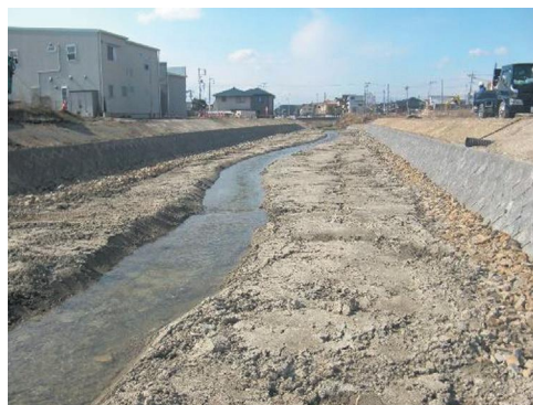
【写真9】長戸川の河道改修
