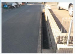
側溝の例 (U型側溝)
