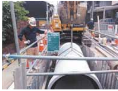
下水管の改築にあわせた能力増強
