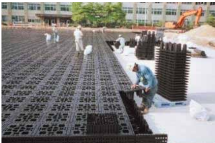
校庭に設置された貯留施設
