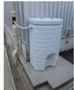
雨水タンクの設置
