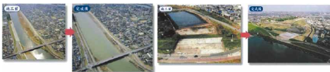
①庄内川 河床掘削(大当郎橋付近)
