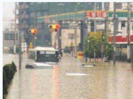
被害状況(天白区野並付近)
