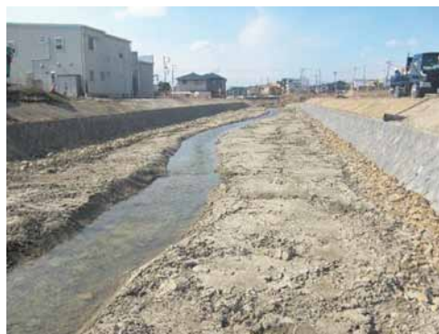
【写真9】長戸川の河道改修
