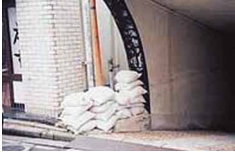
【写真19】地下駐車場における土のう備蓄
