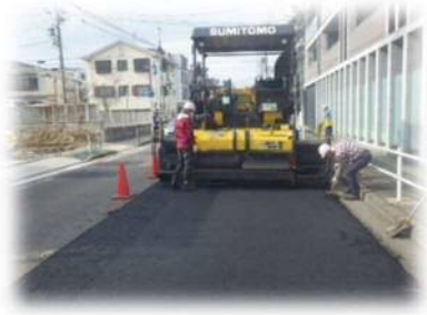
→ 重機で固めます。
