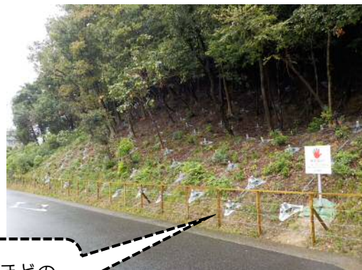
↑完成後の様子
