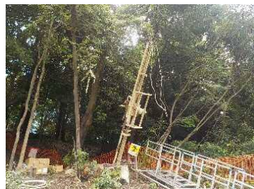
↑ロックボルトを打ち込む機械
