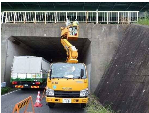
高所作業車による点検
